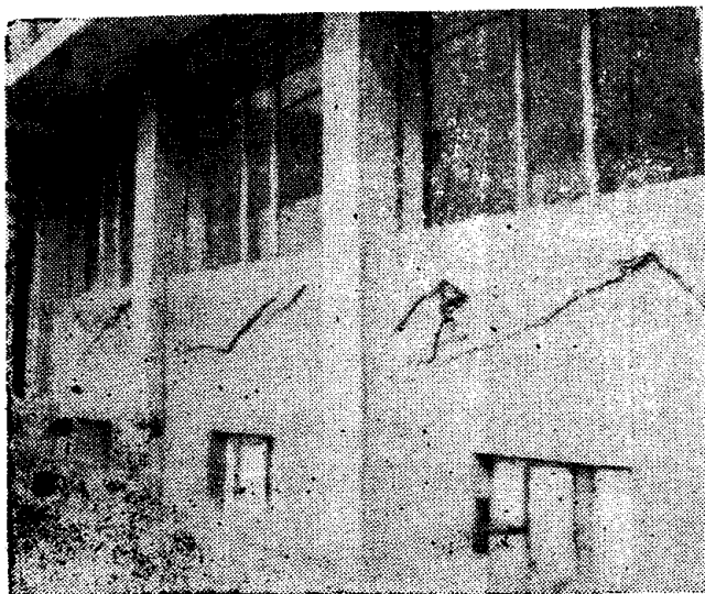
图 1-11 外墙裂缝
