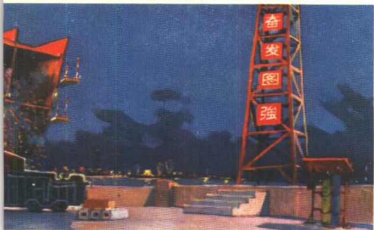
船尾抢修工地
