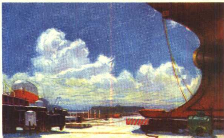
“东方号”建造工地
