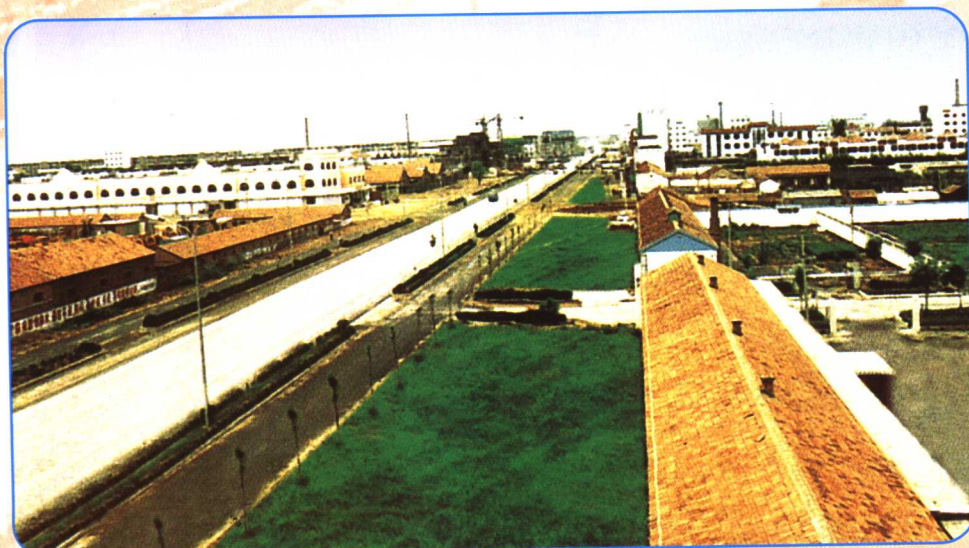
建设中的陈户工业园
