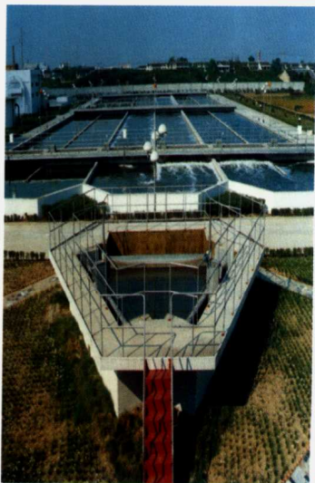
图为已建成投运的生活污水处理厂一期工程
