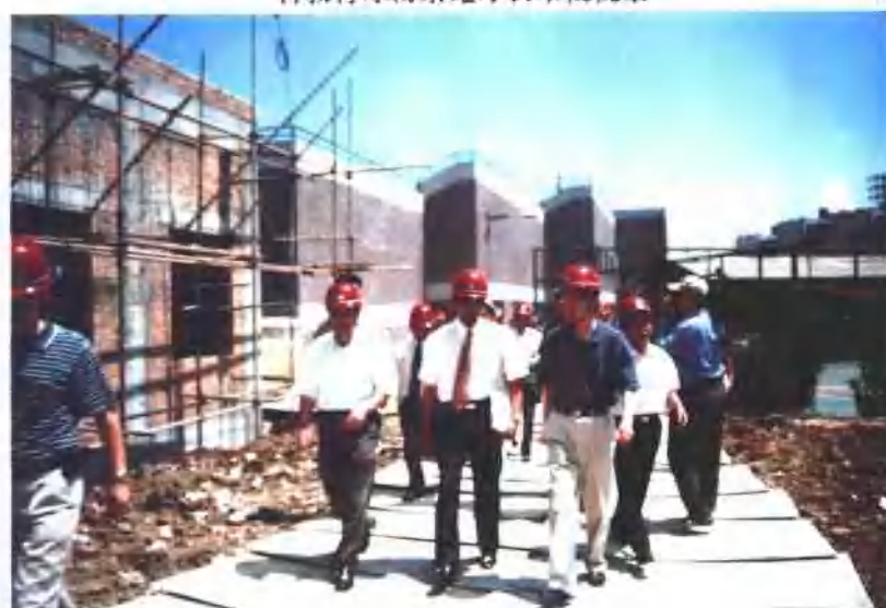
徐荣凯省长，梁公卿副省长 视察我校学生公寓工地
