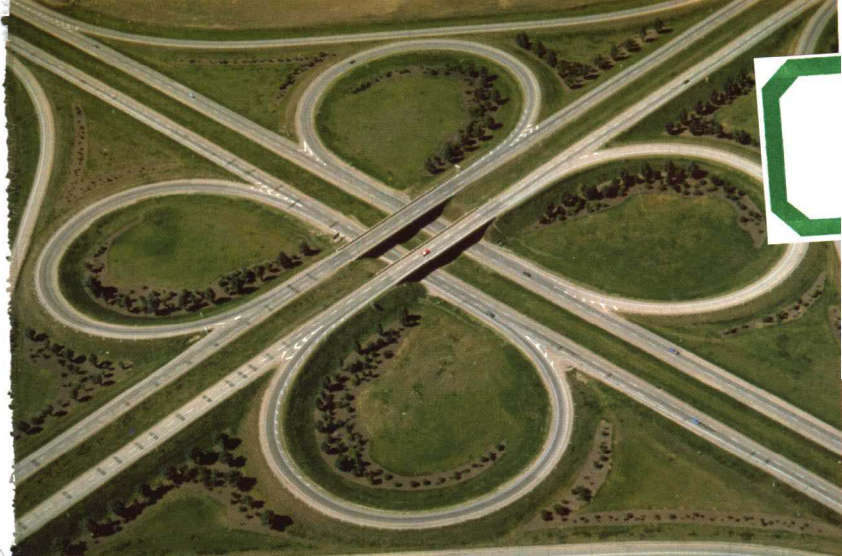
▲ 高速公路上的立交桥
