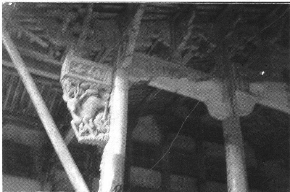
樟林厚厅五檩月梁和后双步梁皆雕有人物、花卉。牛腿图案各异，雕刻刀法硬朗。 (图为厚厅雕花牛腿)
