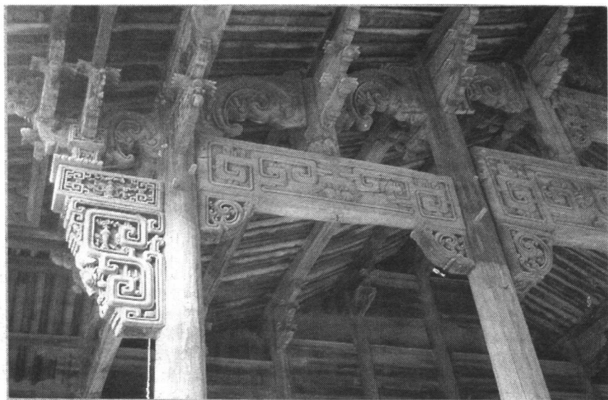
樟林东厅内部均为木结构建筑，雕刻精美，保存完好。（图为雕花屋梁和牛腿）
