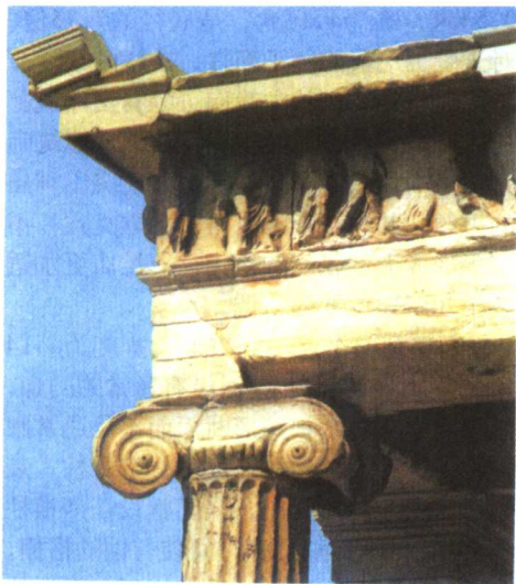
▲ 卡利克拉特试图在胜利神庙中融合多立克与爱奥尼这两种建筑风格。上图为胜利神庙的柱头和柱顶盘近景，该爱奥尼柱式的比例较为粗壮，柱顶盘亦是如此。
