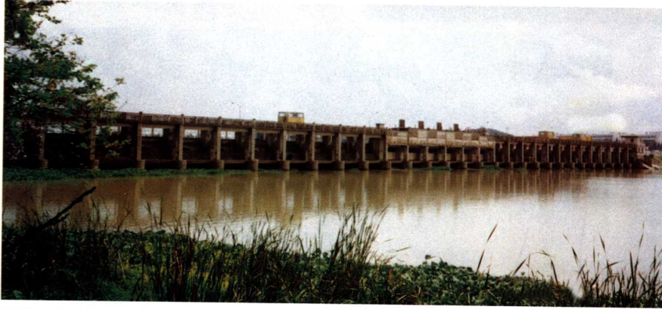
◀ 山美灌区洛阳桥闸
