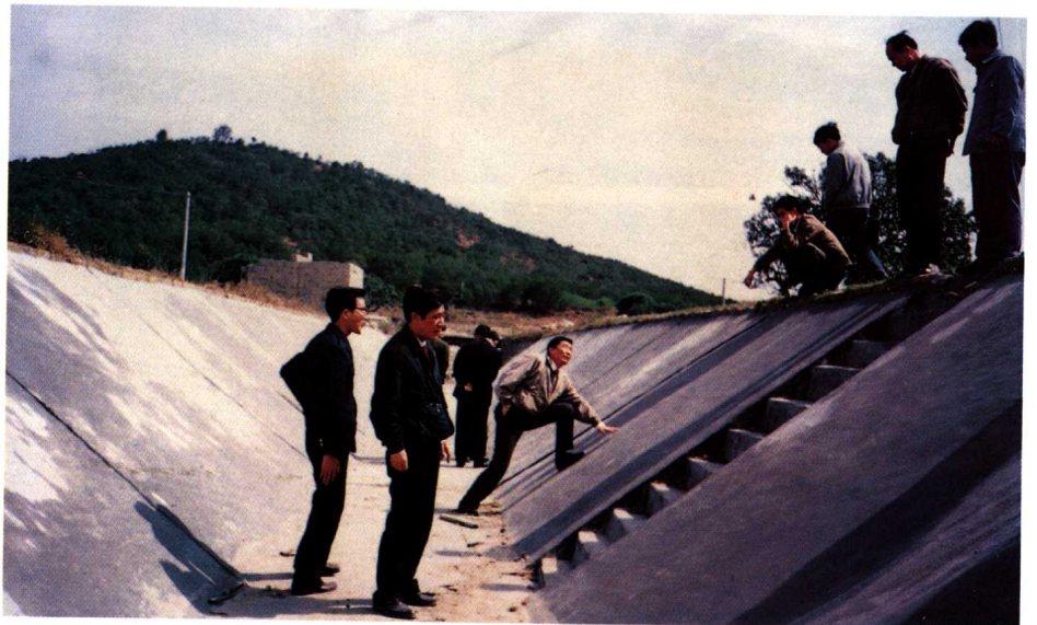
石壁南干渠 防渗渠段 ▶
