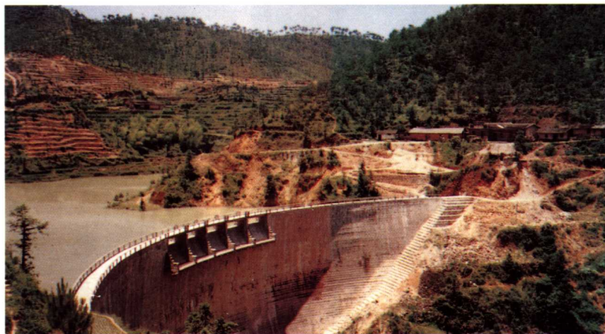
◀ 民主水库大坝
