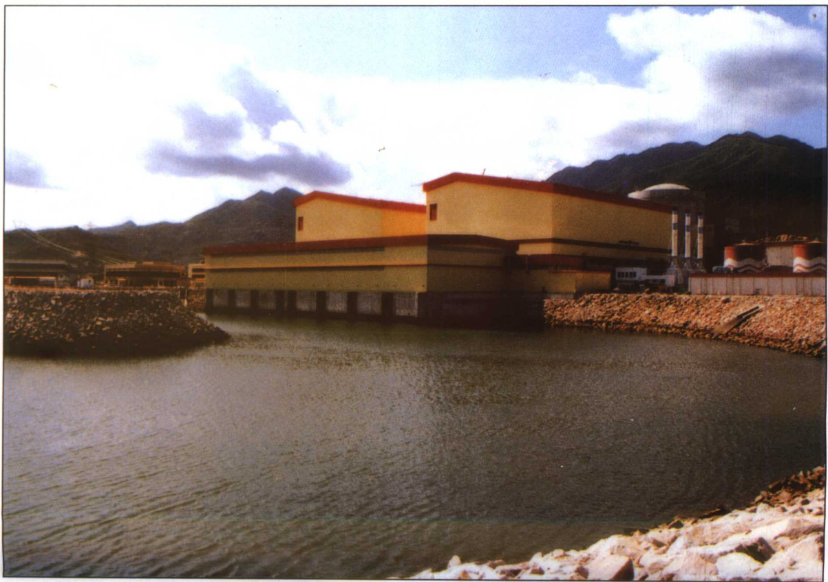
▼ 联合泵站进水口 奚汉民 摄
