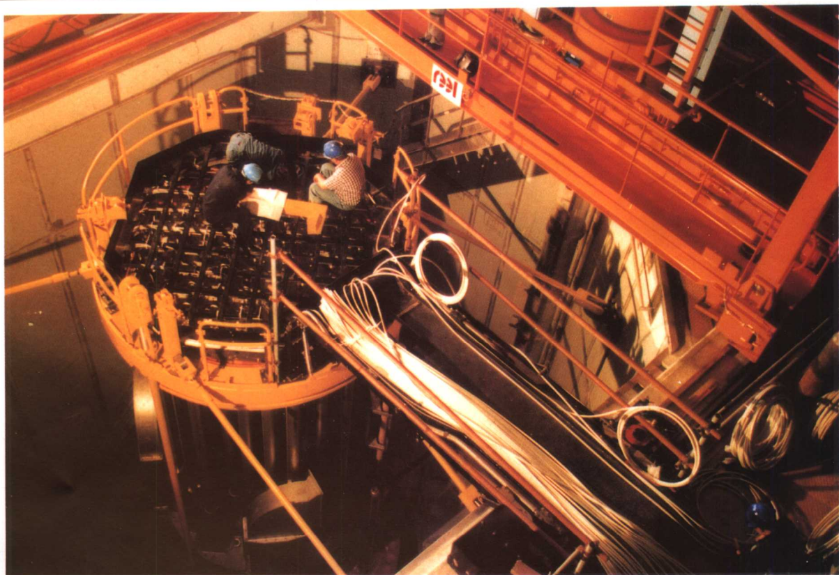
▲ 在安装就位的压力容器顶盖上部安装电缆 奚汉民 摄
