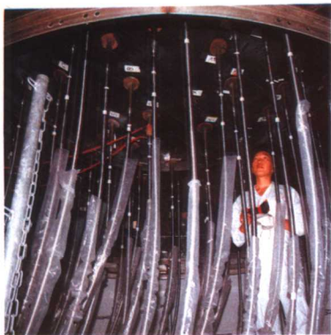
▲正在检查位于压力容器下方的堆芯 测量导管的安装质量 郭瑞珽 摄
