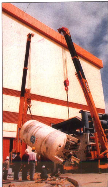
▼ 储气罐吊装
