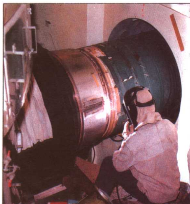
▲主管道与反应堆压力容器管嘴焊接 奚汉民 摄
