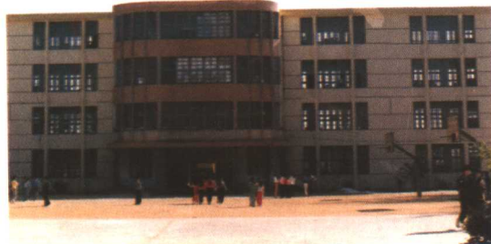
新建的忠门一中教学大楼
