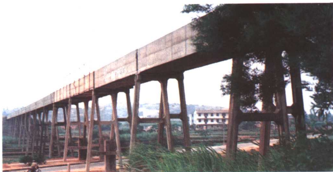
引水工程：坂尾渡槽
