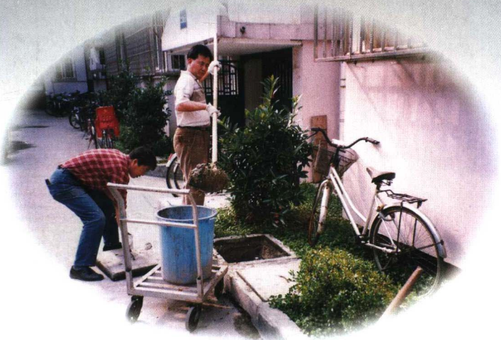
工人疏通管道
