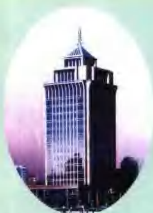
建设中的广播电视中心大楼
