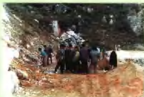
施工人员在抢修水毁公路
