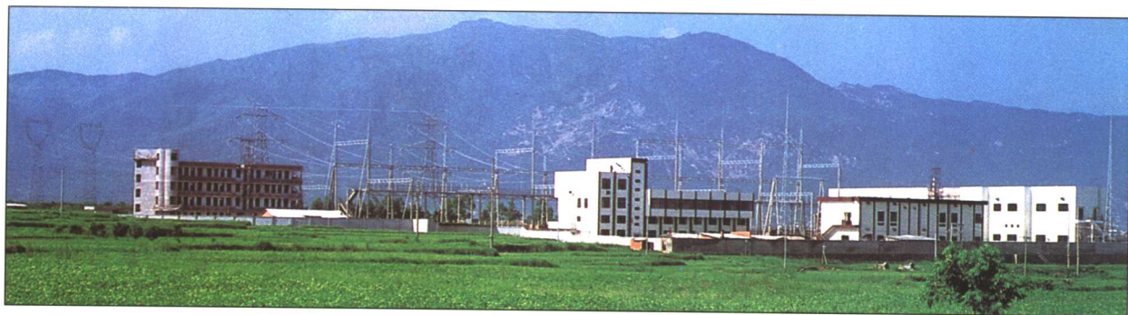
塘西 22 万伏变电站
