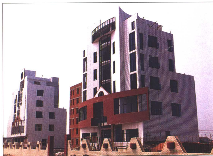
涵江海关、商检姐妹楼
