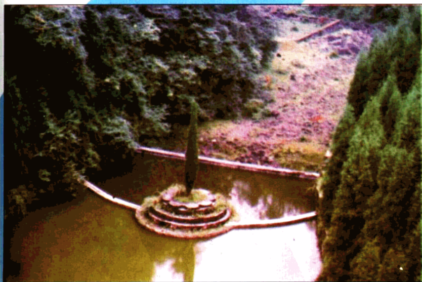
▲ 山虎关水库二坝
