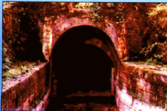
◀ 2520米山尖石 隧洞出口处
