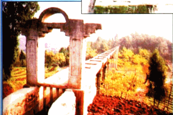
◀ 山虎关水库简村渡槽
