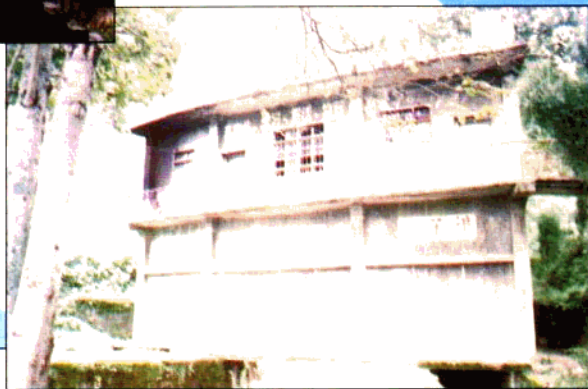
▼ 山尖石隧洞分水闸
