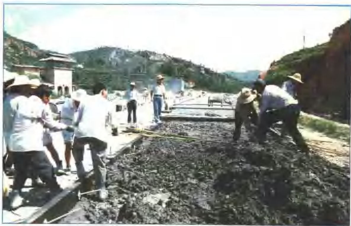
改建工程水泥路面施工剪影
