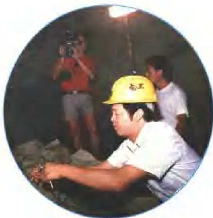
1994年8月8日， 县委书记陈昭扬在隧道 工地点火放炮隧道导坑 贯通
