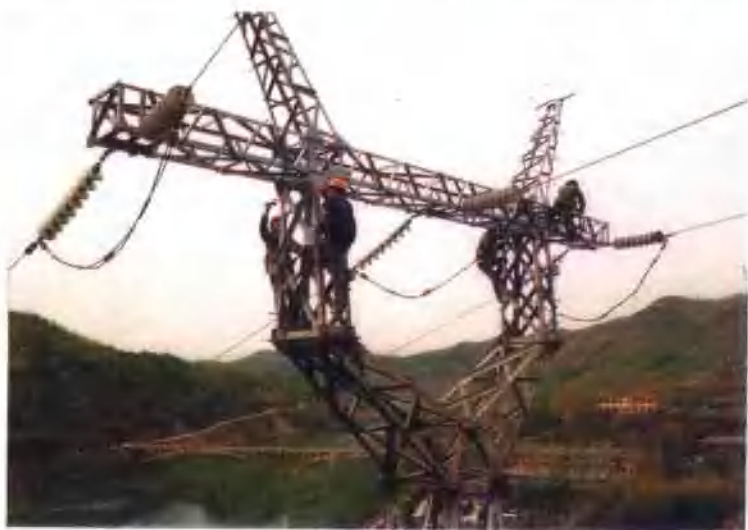
41 110千伏佛—六—合线路检修
