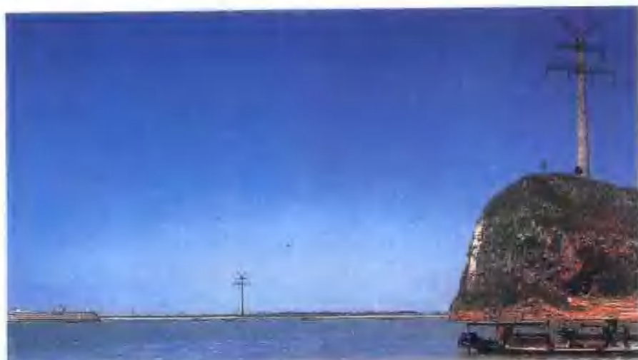
43 1960年建成的220千伏东西梁山长江大跨越
