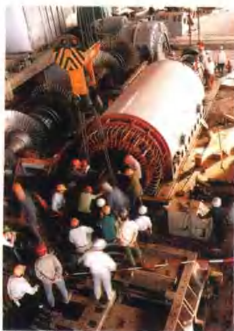
16 安徽电建一公司职工在洛河发电厂 工地为30万千瓦发电机穿转子
