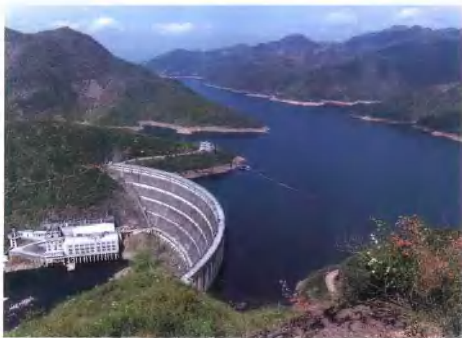
32 响洪甸水电站(总容量4万千瓦)
