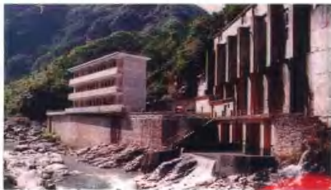
36 毛尖山水电站(总容量2.5万千瓦)
