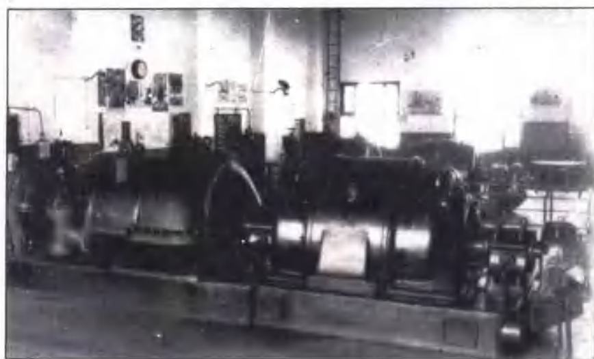
7 旧中国时期芜湖明 远电灯公司发电机 (总容量2160千瓦)
