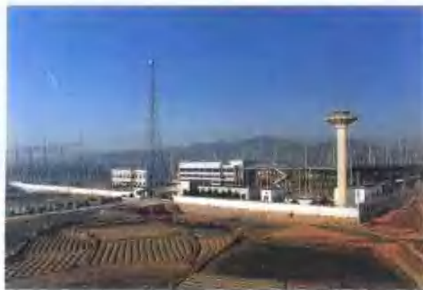
56 500千伏繁昌变电所
