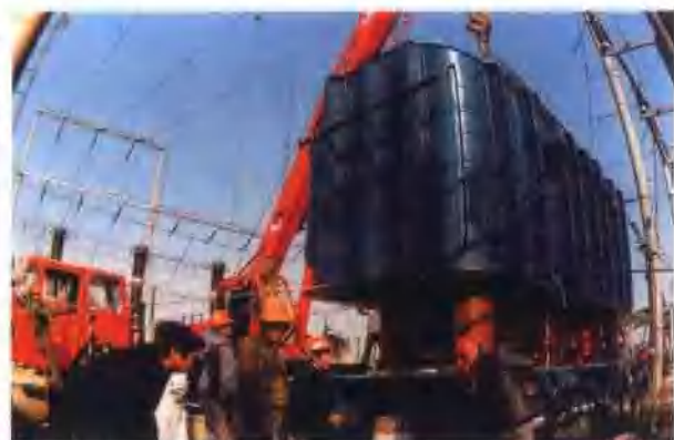
47 220千伏淮南西山变电所主变压器吊罩
