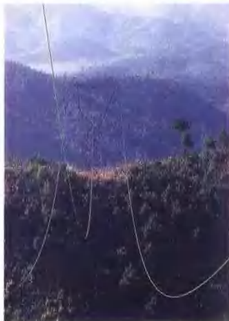
45 220千伏长龙山——火龙岗——田柳线路
