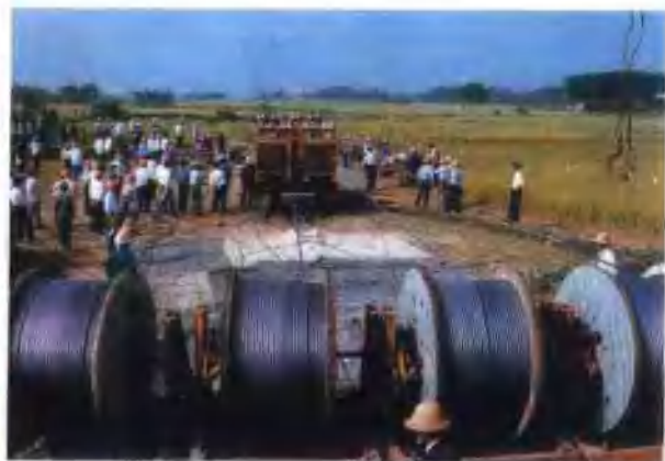
50 安徽送变电工程公司500千伏 输电线路张力放线
