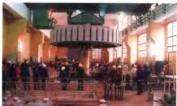
34 陈村水电站水轮发电机吊转子
