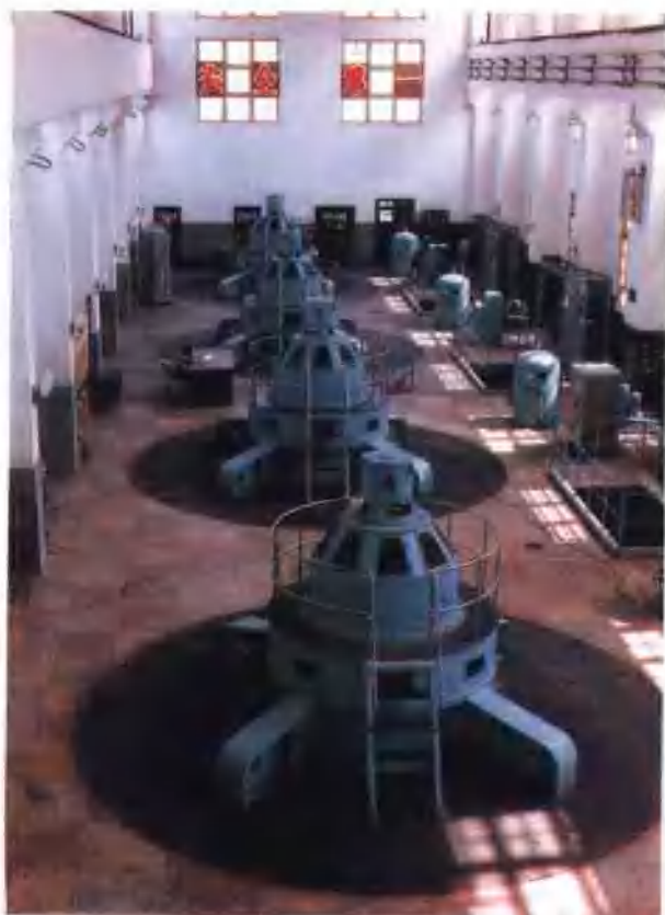
37 花凉亭水电站4台1万千瓦发电机
