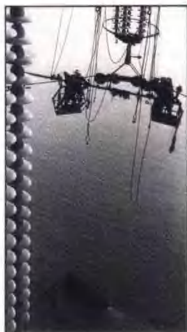
44 1980年220千伏东西梁山大跨越更换导线工程
