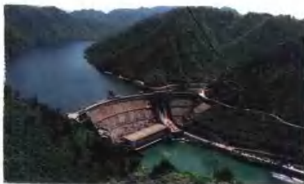
33 陈村水电站(总容量15万千瓦)
