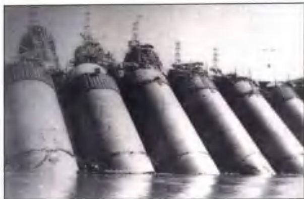
30 1955年梅山水电站大坝施工场景
