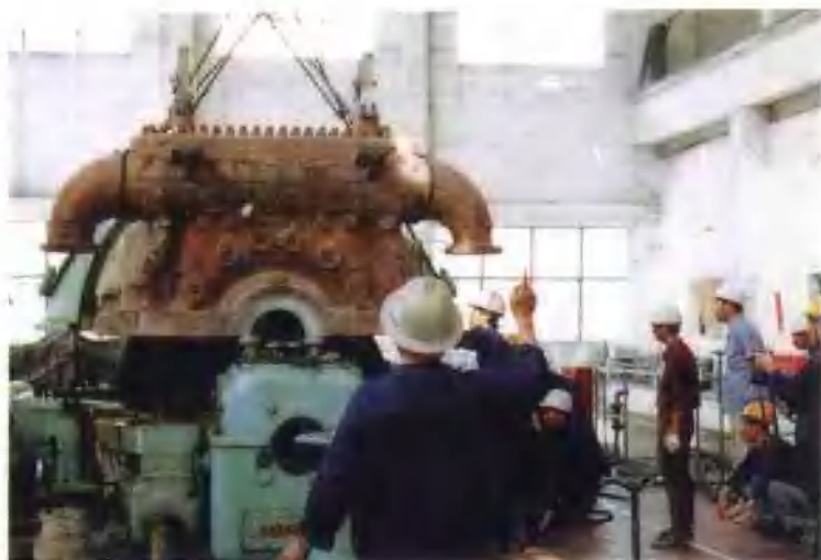
13 贵池发电厂汽轮机检修
