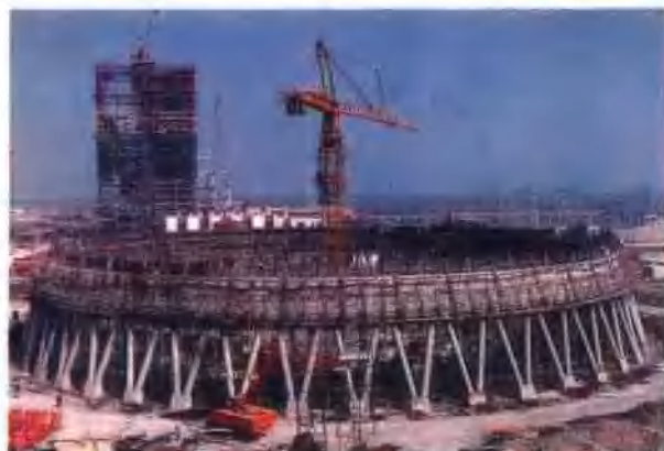
19 安徽电建二公司采用爬模工艺建造平圩发电厂6500平方米冷却水塔
