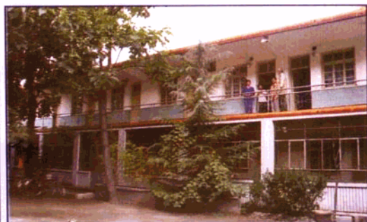
煤炭化验站化验室
