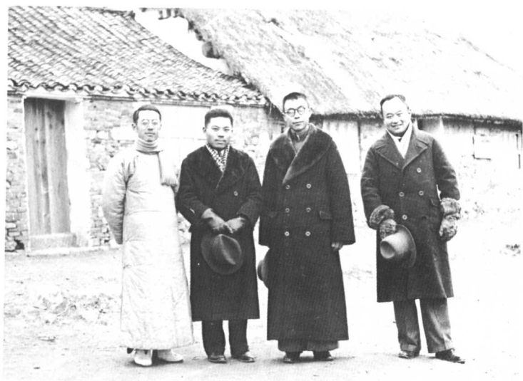
在江南水泥厂施工工地（左起：徐莘农、王涛、陈范有、庾宗淮）（1934）
