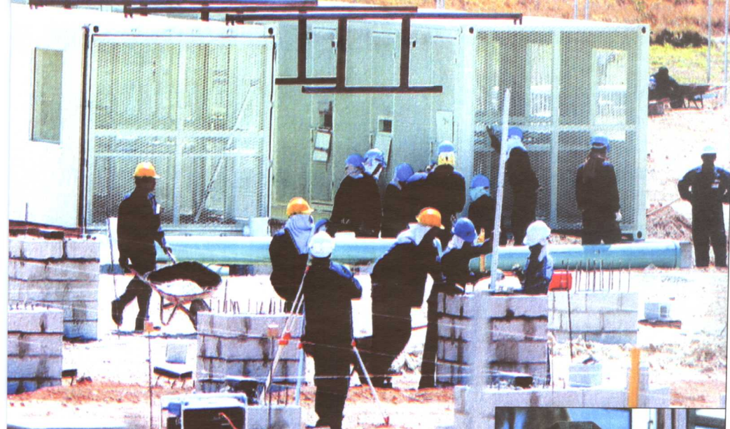
↑ 美国施工人员在扩建关塔那摩监狱设施。
