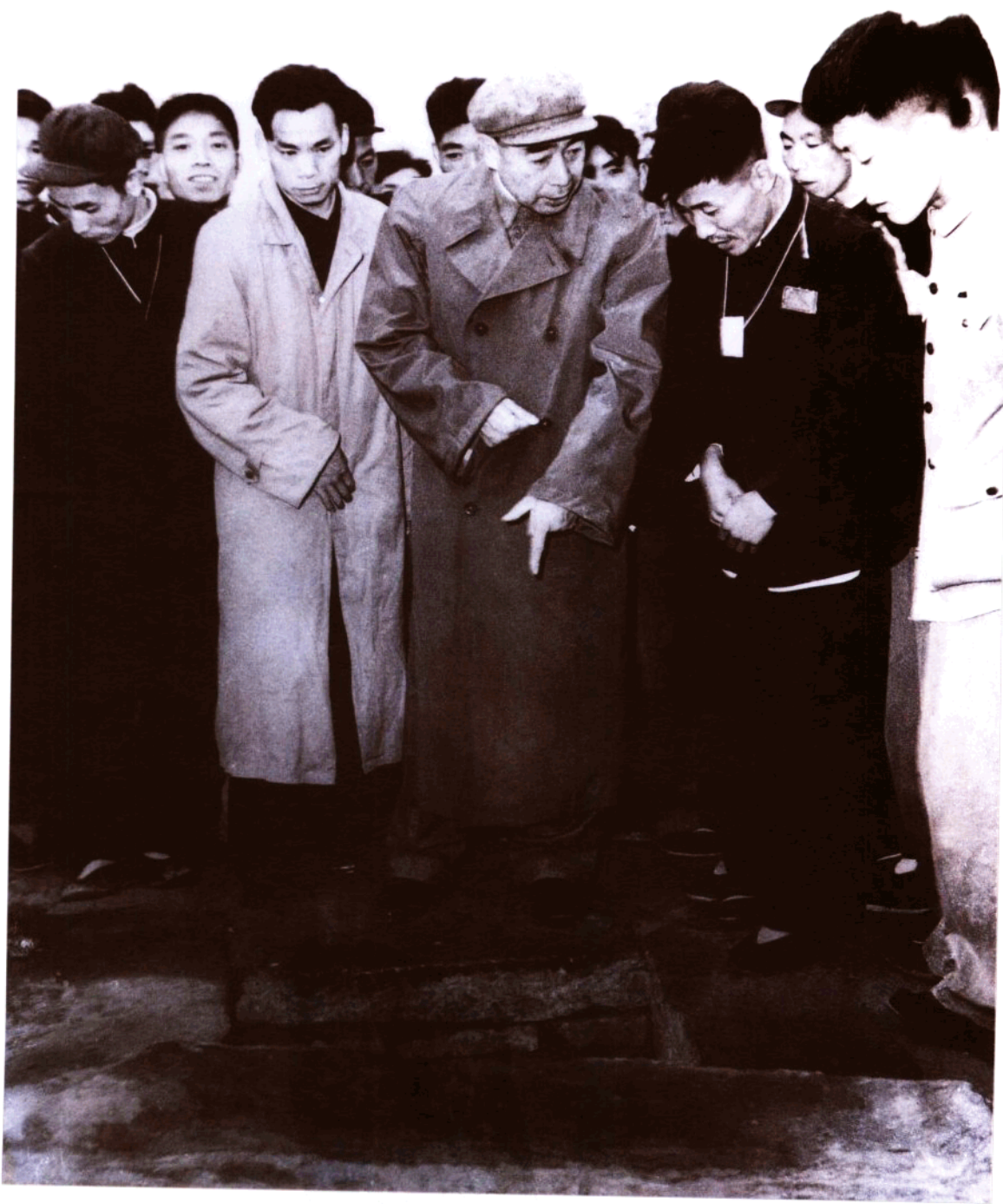
周恩来总理视察偃师市井灌地埋输水管道工程(1958年10月)
