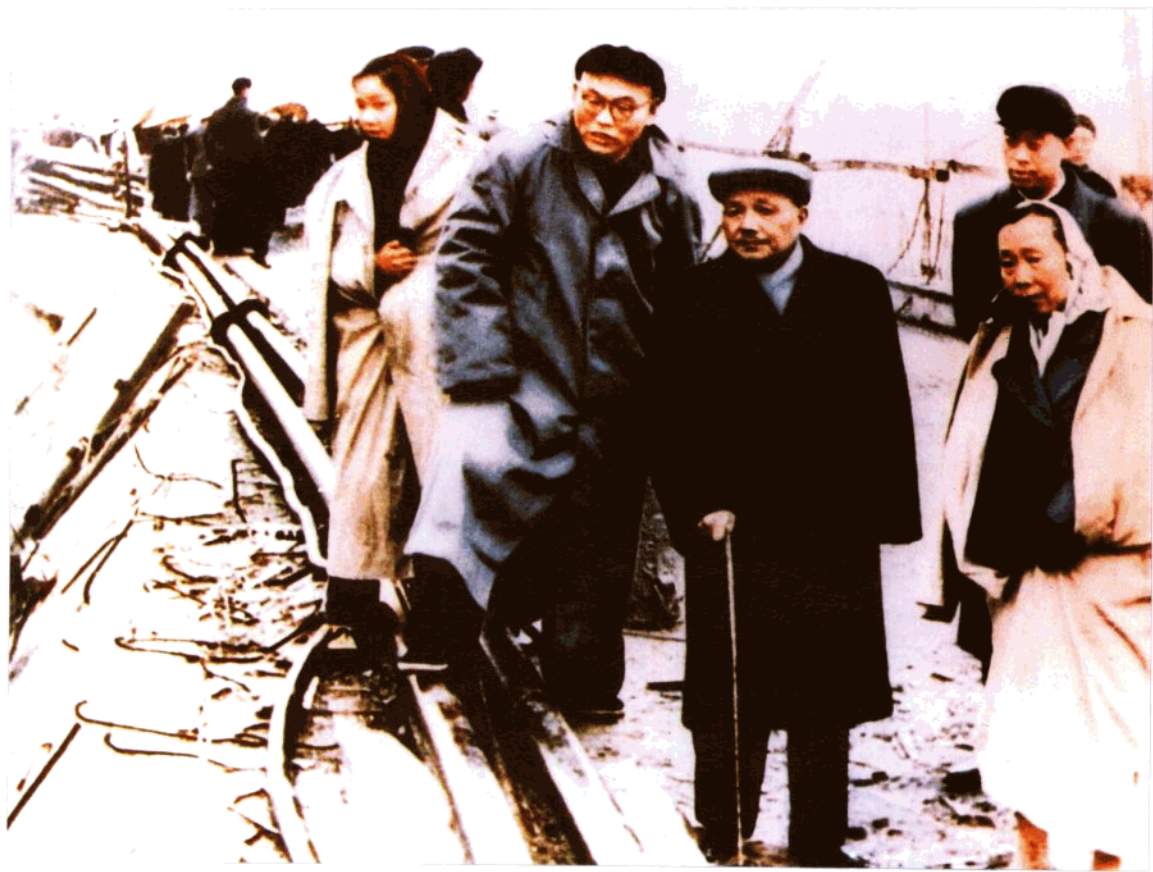
邓小平同志视察黄河三门峡水库工程（1961年3月）
