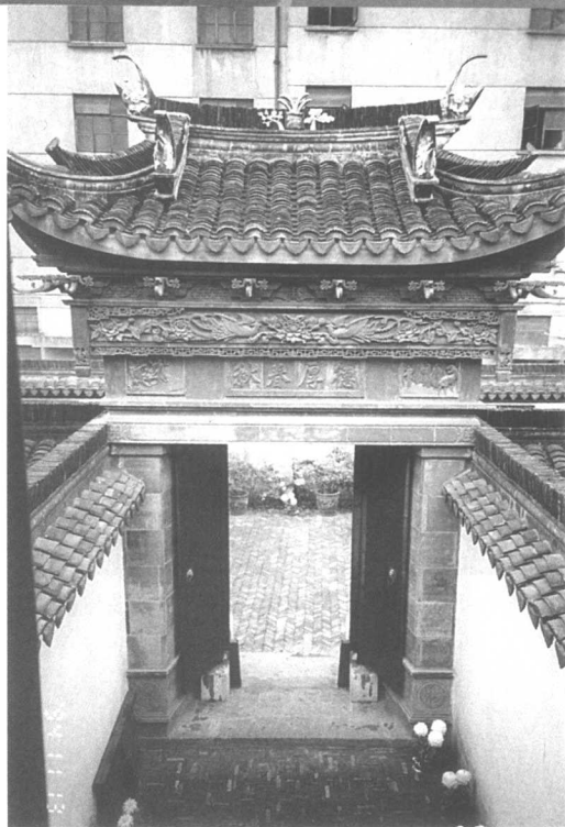
图 1-1-7 一字脊正中“万年青”（浦东川沙镇黄宅）
