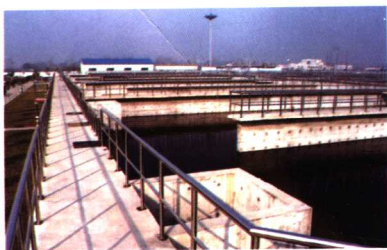
▲ 山东枣庄薛城污水处理厂
