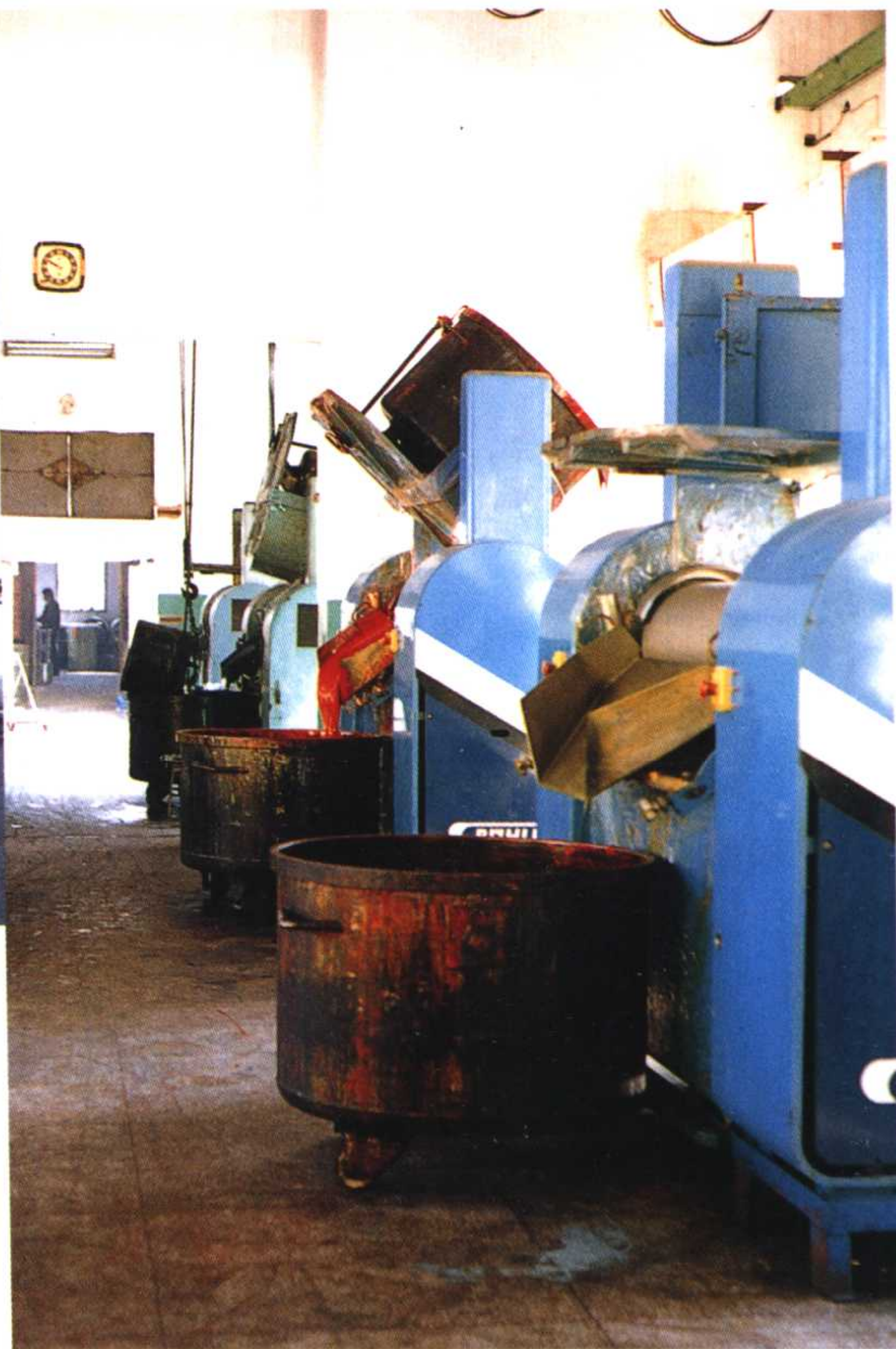
△福州油墨厂生产车间
