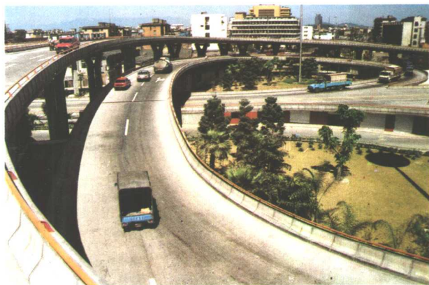
福州五里亭立交桥
