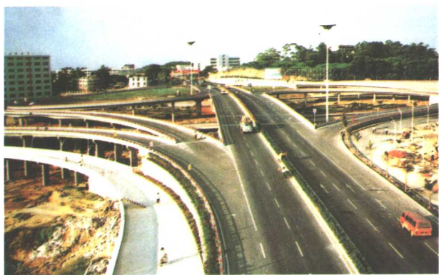
厦门厦鼓立交桥
