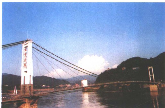
南平九峰山悬索桥
