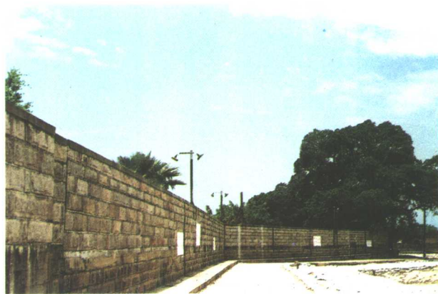
福州市区防洪堤
