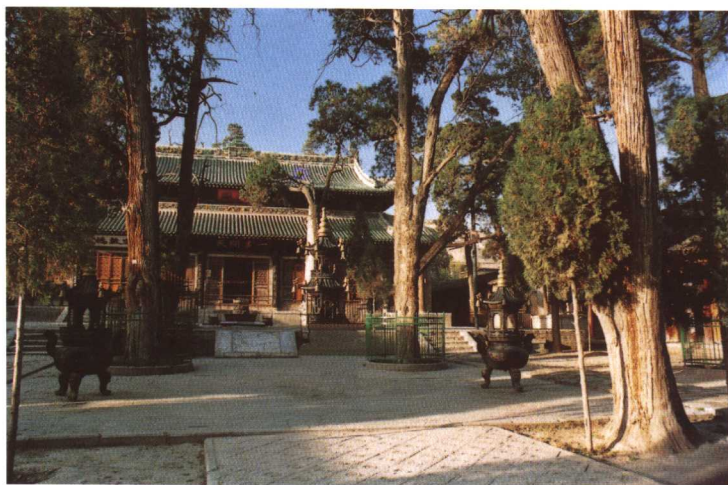
伏羲庙先天殿
