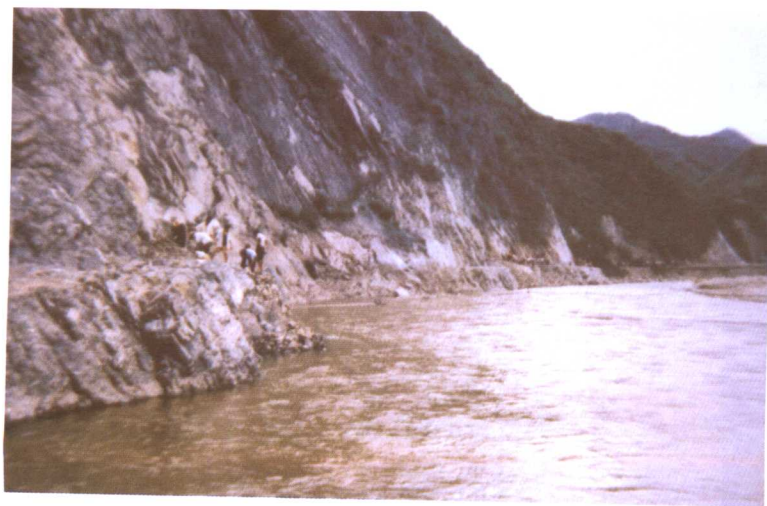
1998年8月25日，洪水冲 毁商南县清泉路
