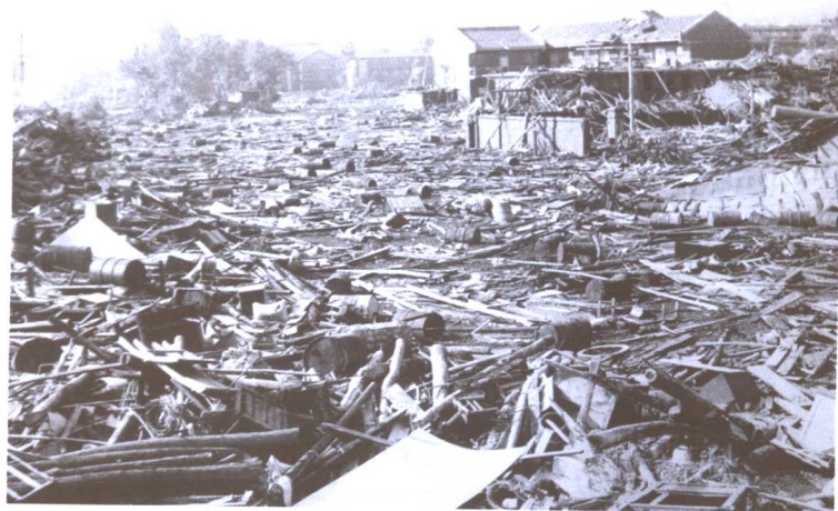
1983年8月1日，安康老城区大桥以南至油厂地段因洪水变为废墟
