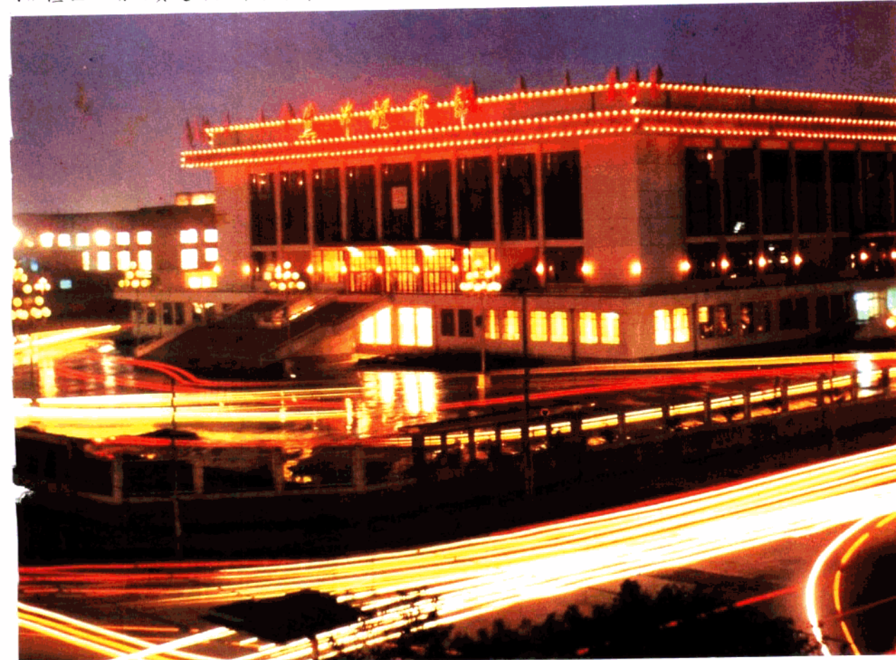
用炉渣空心砌块填建的焦作市体育馆
