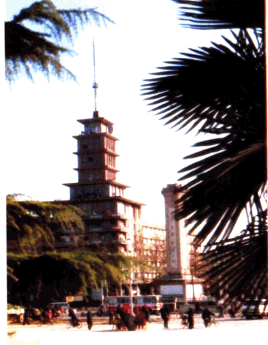
左图：用空心砌块盖起的焦作市电视大楼
