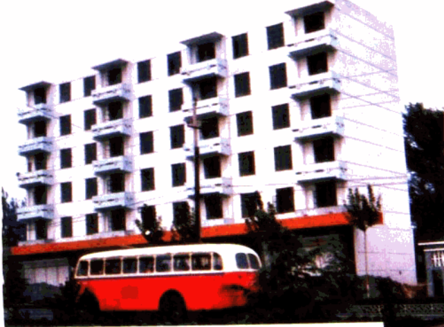
◁用粉煤灰砖兴建的工厂家属楼
