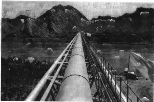
图 1.2-1 西气东输的中卫黄河跨越工程
