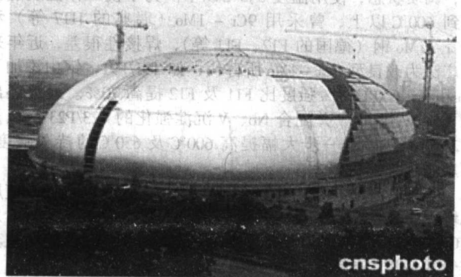
图 1.2-8 建设中的国家大剧院
