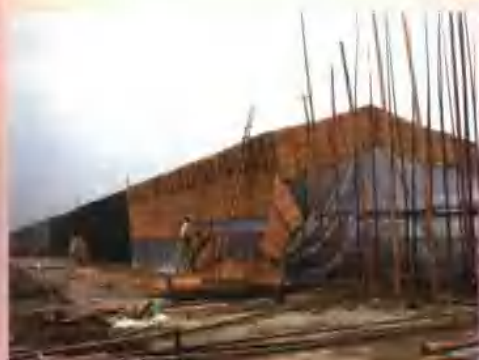
建设中的高棚层架菇房
