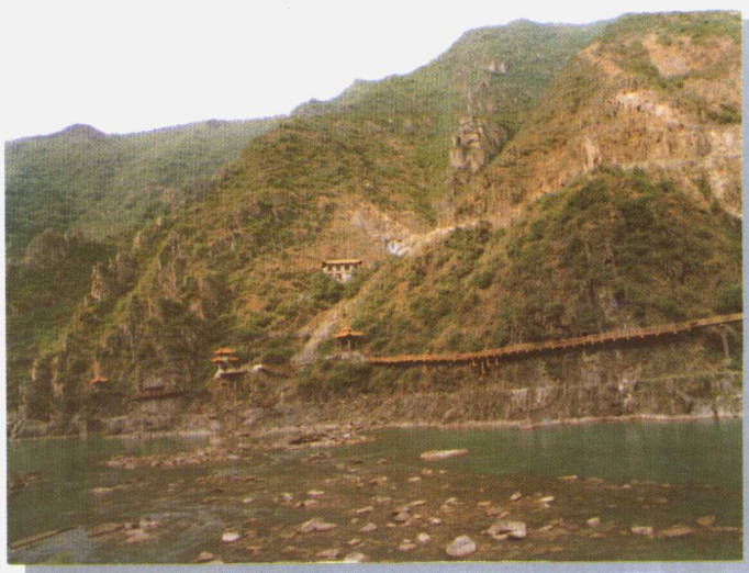
修复的石门栈道
