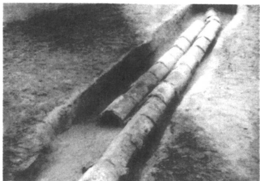
汉长安城未央宫排水管道
