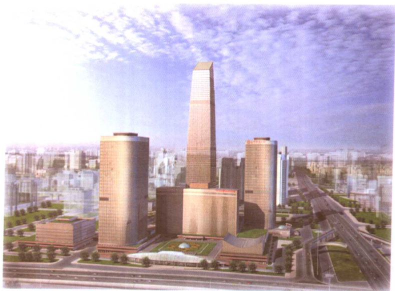
中国国际贸易中心三期工程。
