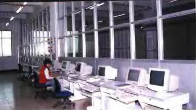
数字移动电话机房
