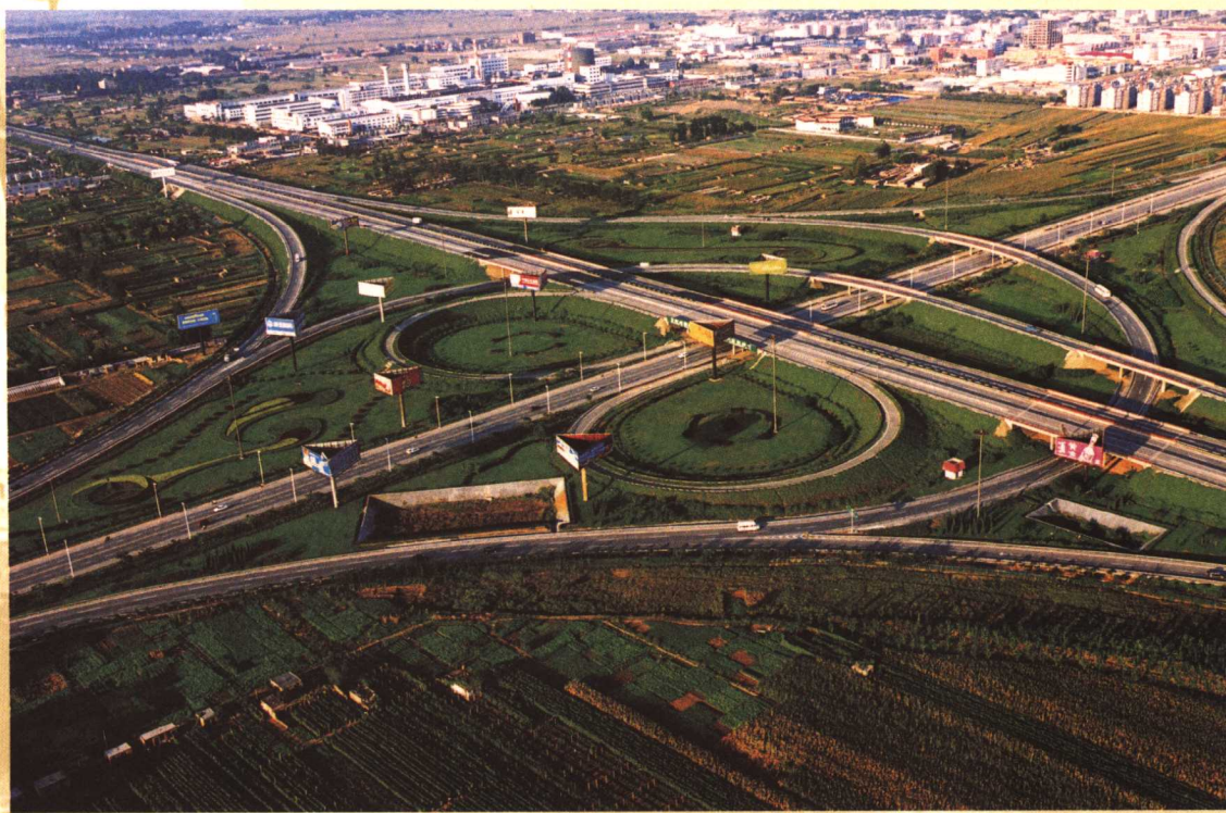
京石高速公路立交桥
