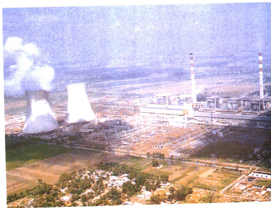
山东装机容量最大的邹县发电厂（240万千瓦）
