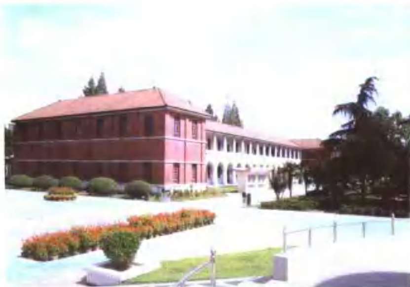
工字形教学楼 ▼
