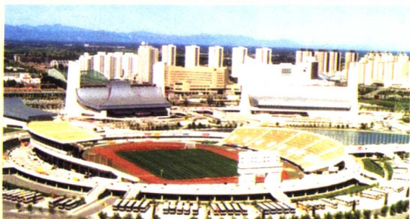
亚运村体育中心，田径场和游泳馆。
