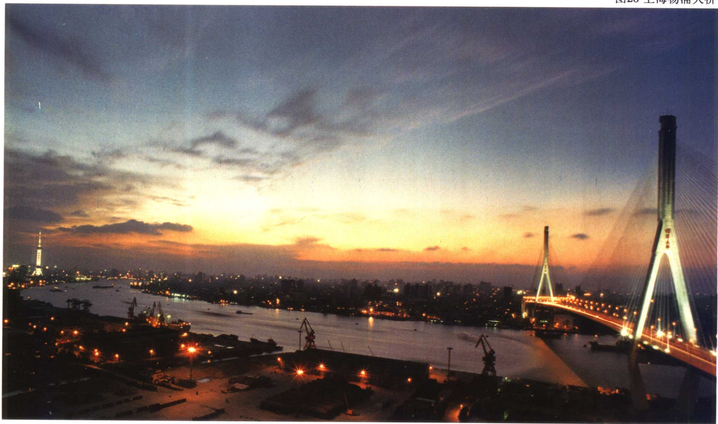
图23 上海杨浦大桥
