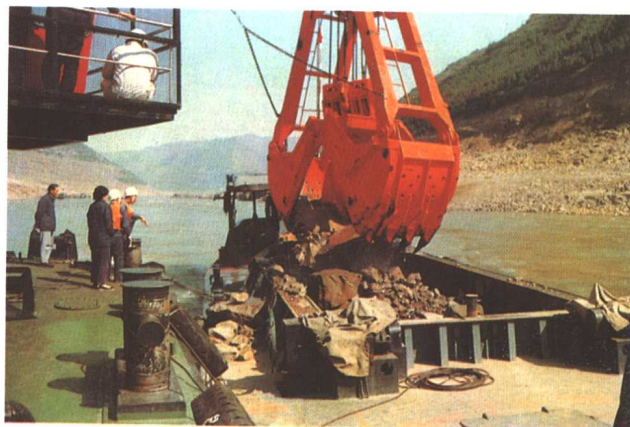
抓斗挖泥船在川江急流滩施工
