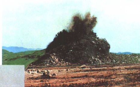
土石方控制爆破
