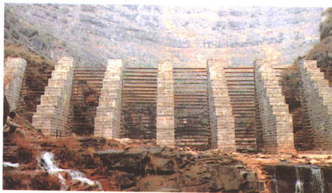
在泥石流多发的溪沟中筑起栅栏坝
