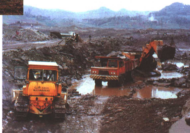
爆破、挖掘、运输配套的机械化施工
