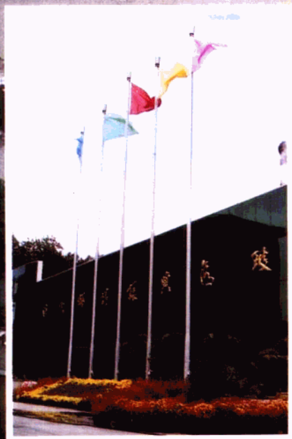
公司大门内玻璃幕墙
