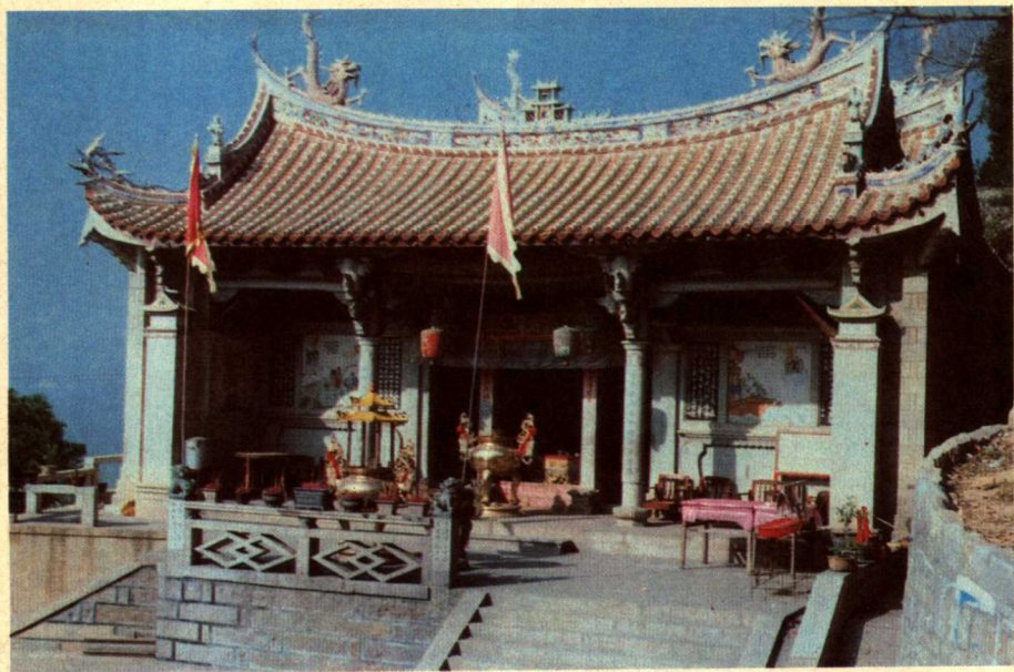
湄洲祖廟寢殿(正殿)
