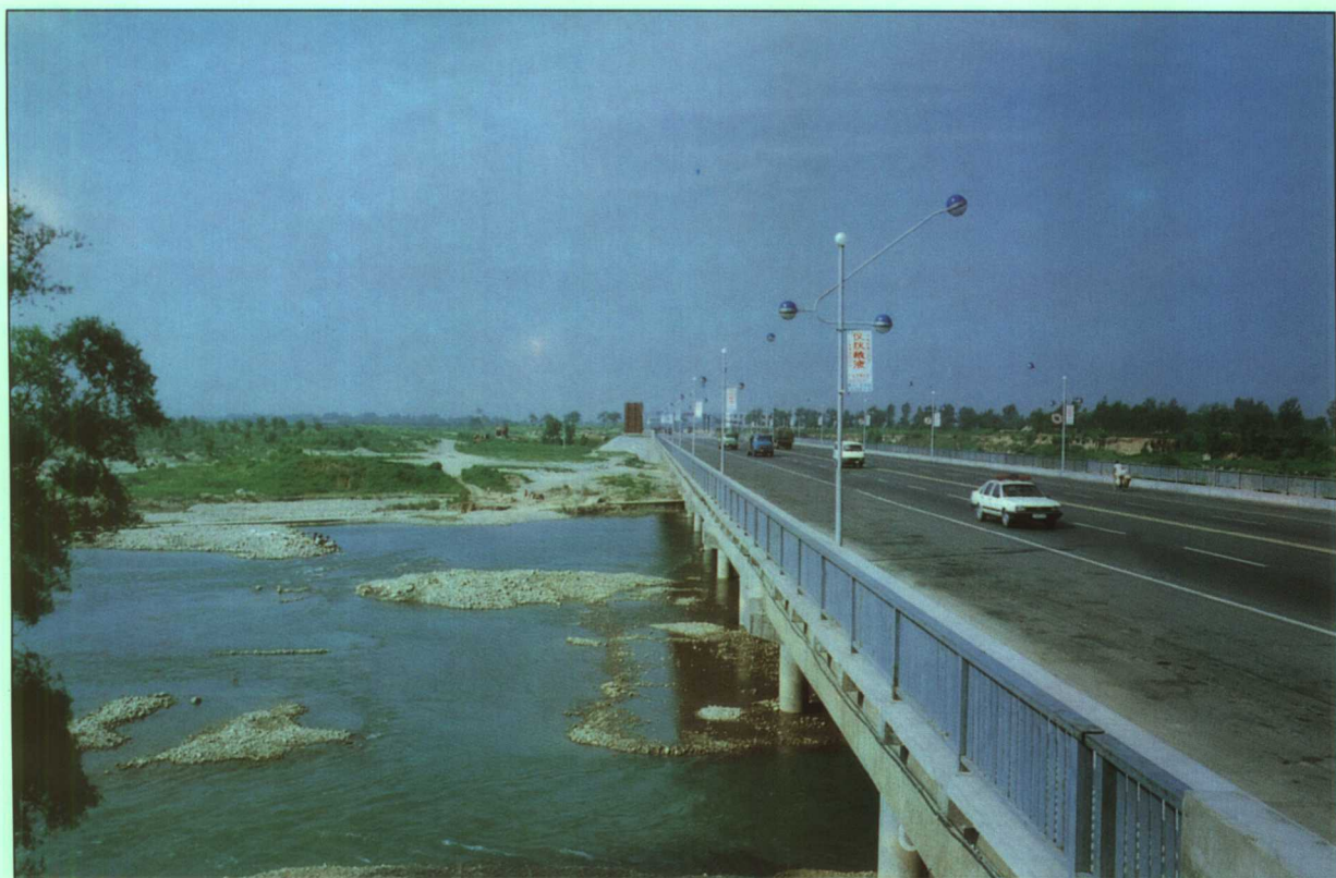
河南省最宽的公路桥 —— 107国道淇河大桥
