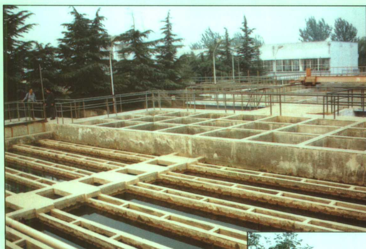
自来水厂沉淀反应池
