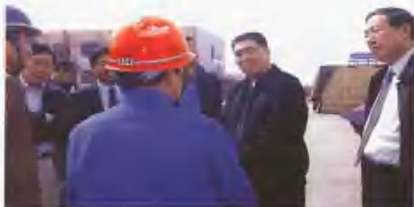
2004年4月28日，省长李成玉（右二）在新密市刘寨镇河南盛润电力实业有限公司盛润电厂施工现场视察和指导工作。
