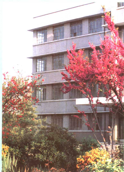
实验大楼一角
