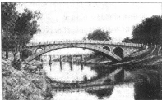
图 1-1-1 河北赵县赵州桥(公元 605 年)
