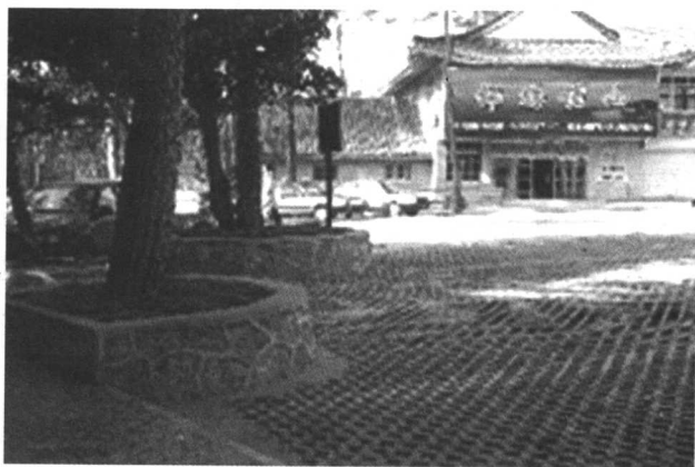
图 1-3 中山陵景区停车场嵌角砖透水性铺装实录
