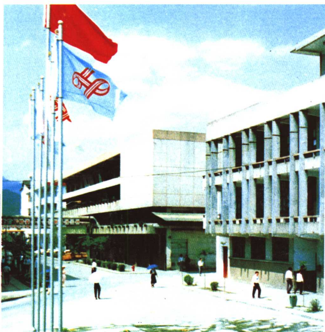
▲三明印染厂厂区
