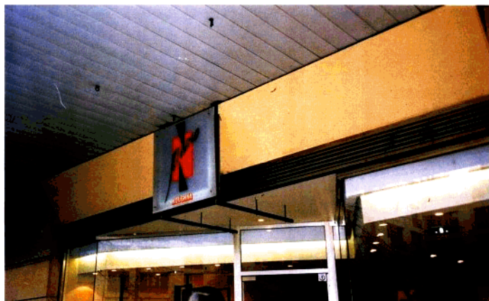
1·9 铝合金扣板吊顶在商业空间中的运用。
