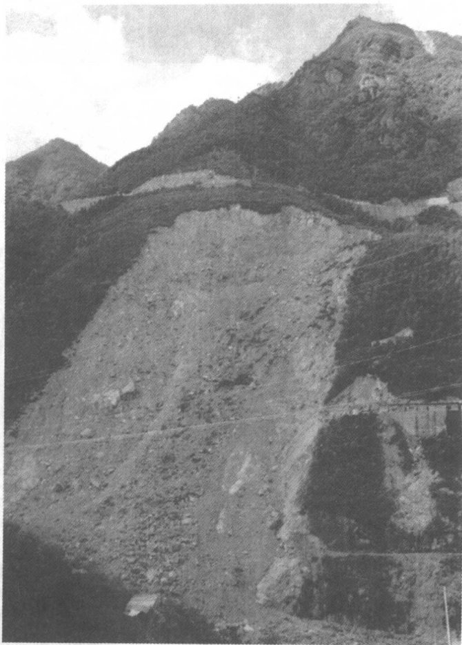
图 1.3 天荒坪抽水蓄能电站下池的“大溪滑坡”
