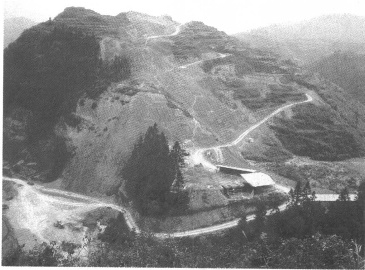
图 1.1 贵州省平溪滑坡
